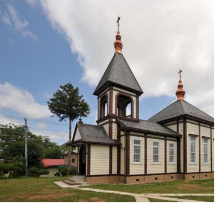
修復工事の完了した金成正教会聖使徒イオアン聖堂
