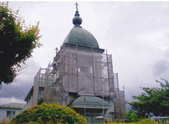
修復工事中の盛岡正教会十字架挙栄聖堂
